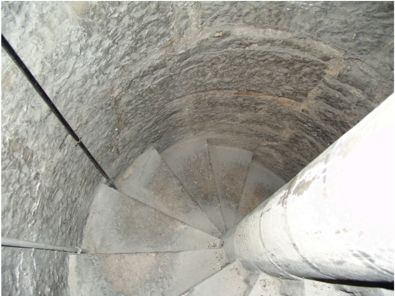
Escalier du clocher
