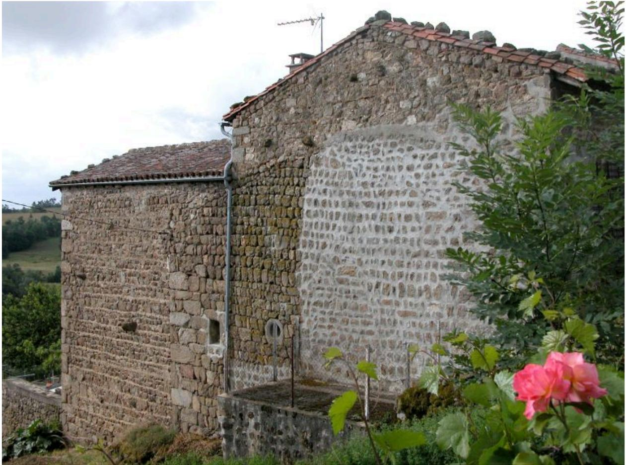
Elévation arrière du logis. Traces de mise en oeuvre des matériaux différentes et d'agrandissements.
