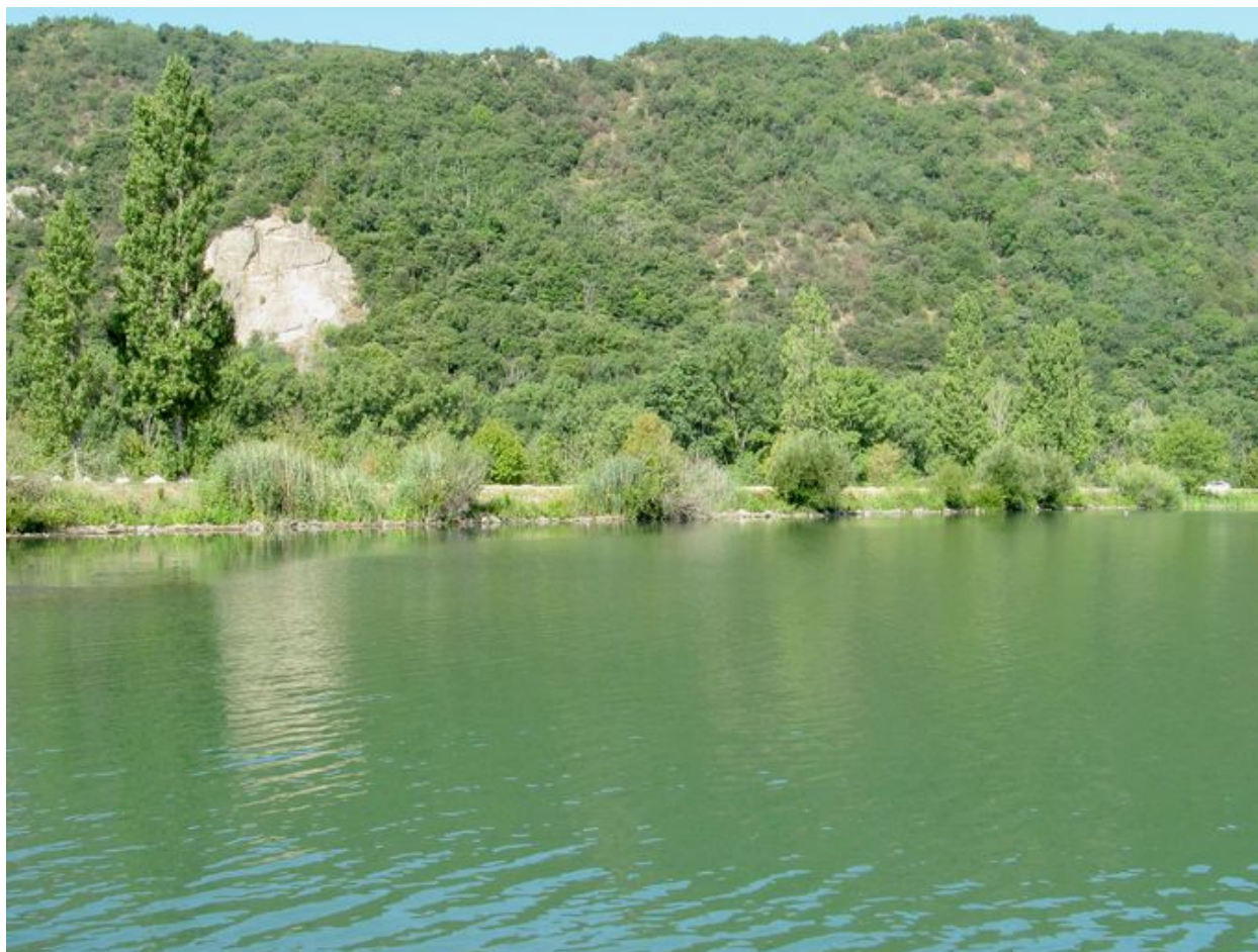
Pont-digue de la rive droite, vue générale
