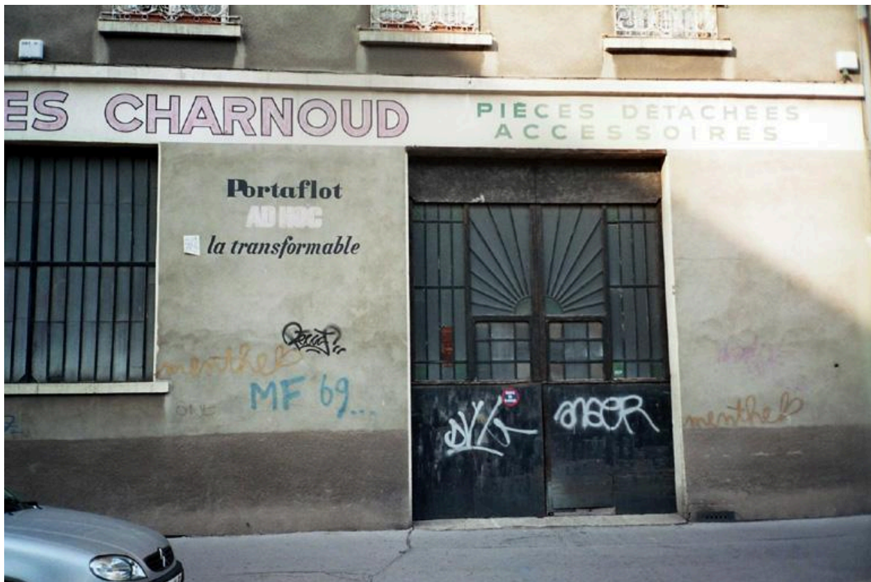
Détail portail entrée
