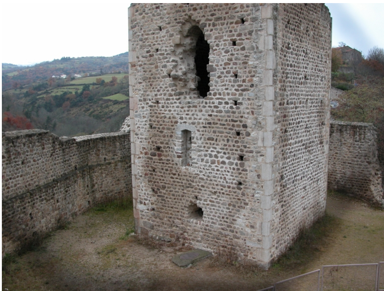
Vue d'ensemble du donjon depuis la tour clocher de l'église, de l'est.
