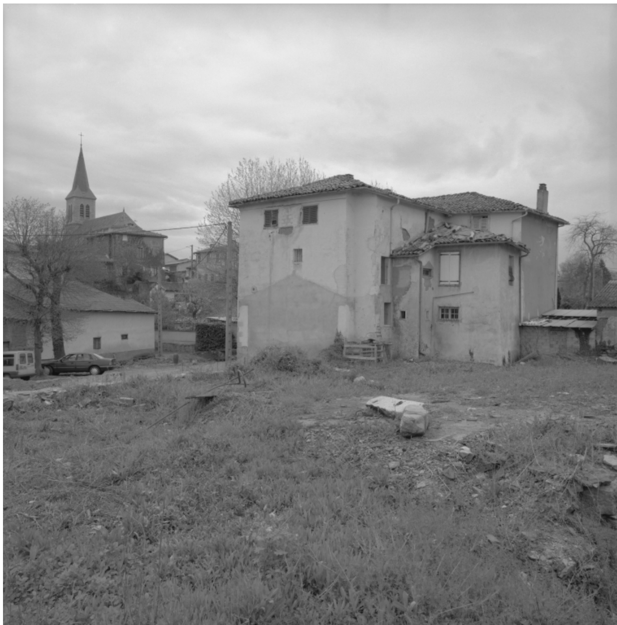
Vue d'ensemble de la maison et du pigeonnier, du nord-ouest.
