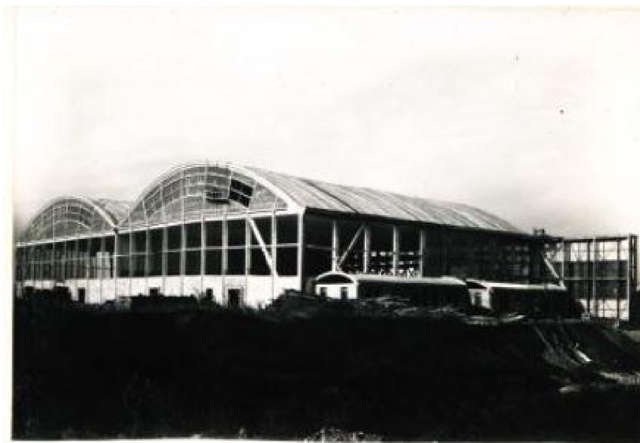
Hangar VI photo chantier ETs. Boussiron 1925 (ADR : 4535W47)
