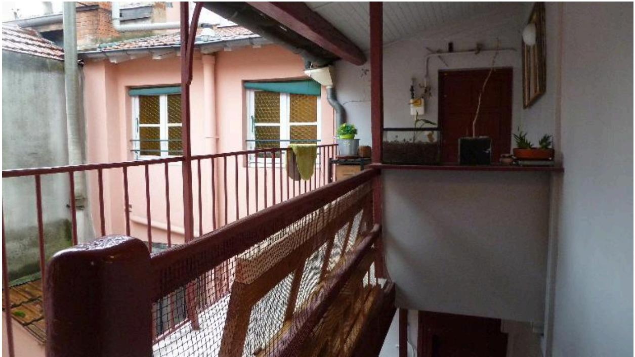
Vue depuis le dernier niveau de l'escalier
