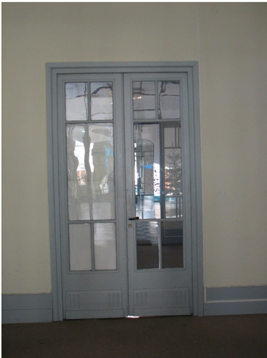
porte des grands bureaux
