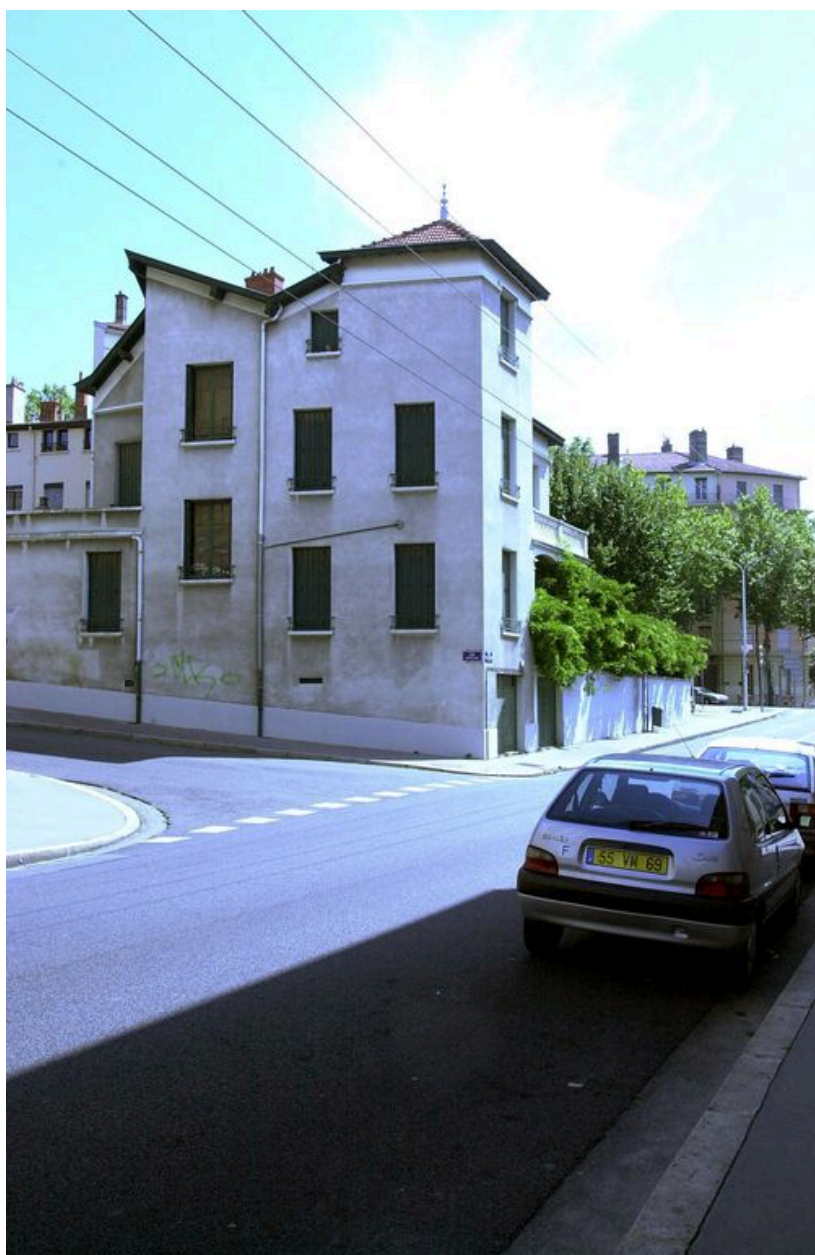
Vue générale depuis la rue Philippe-de-Lassalle
