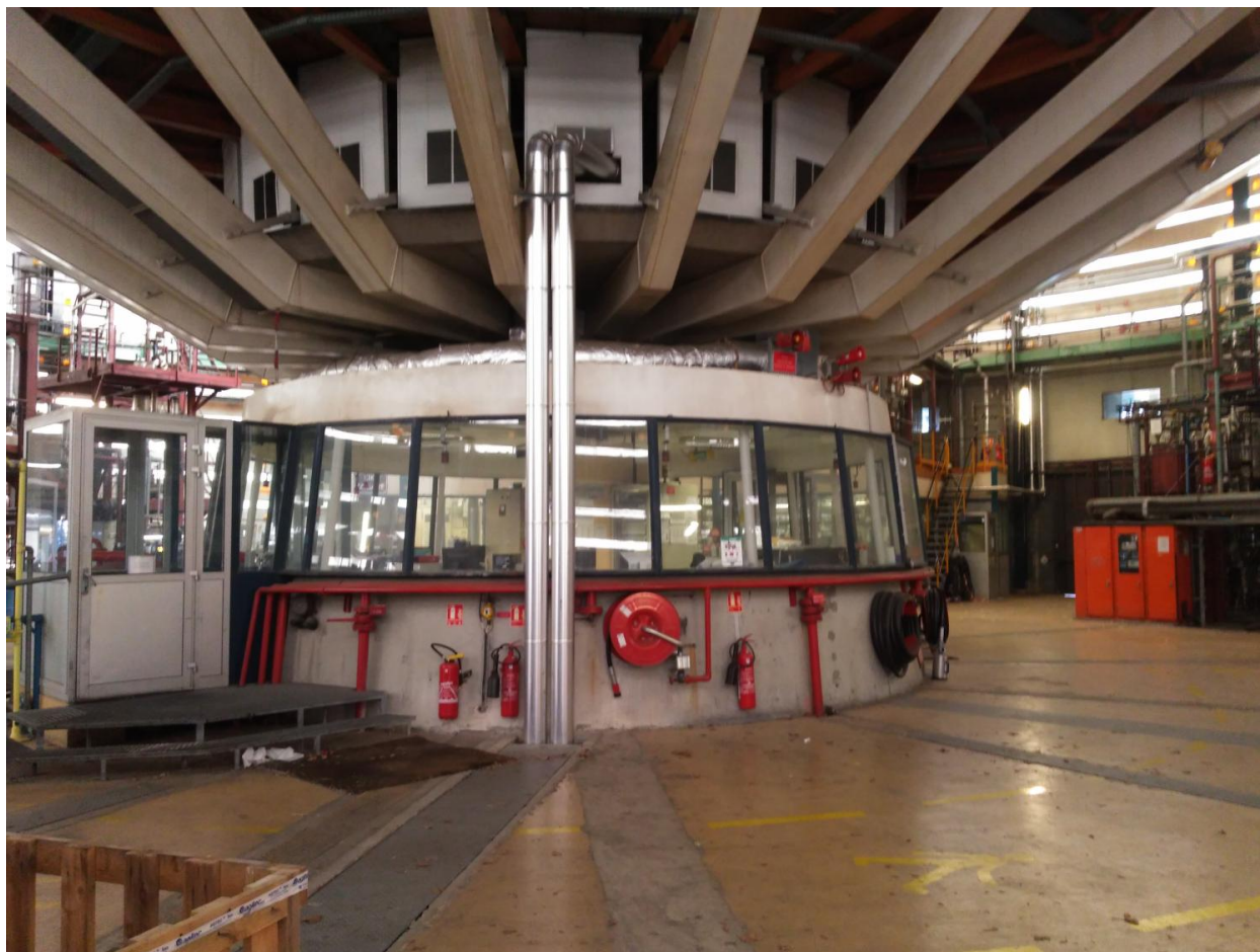
Poste de contrôle (vue d'intérieur vers 2001)
