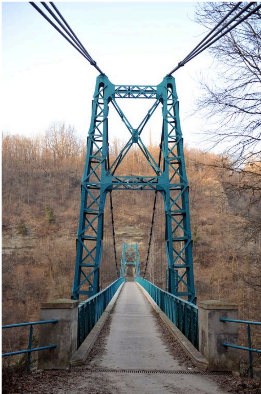
Vue générale, de dessus, chaussée et pylônes (depuis la rive gauche)
