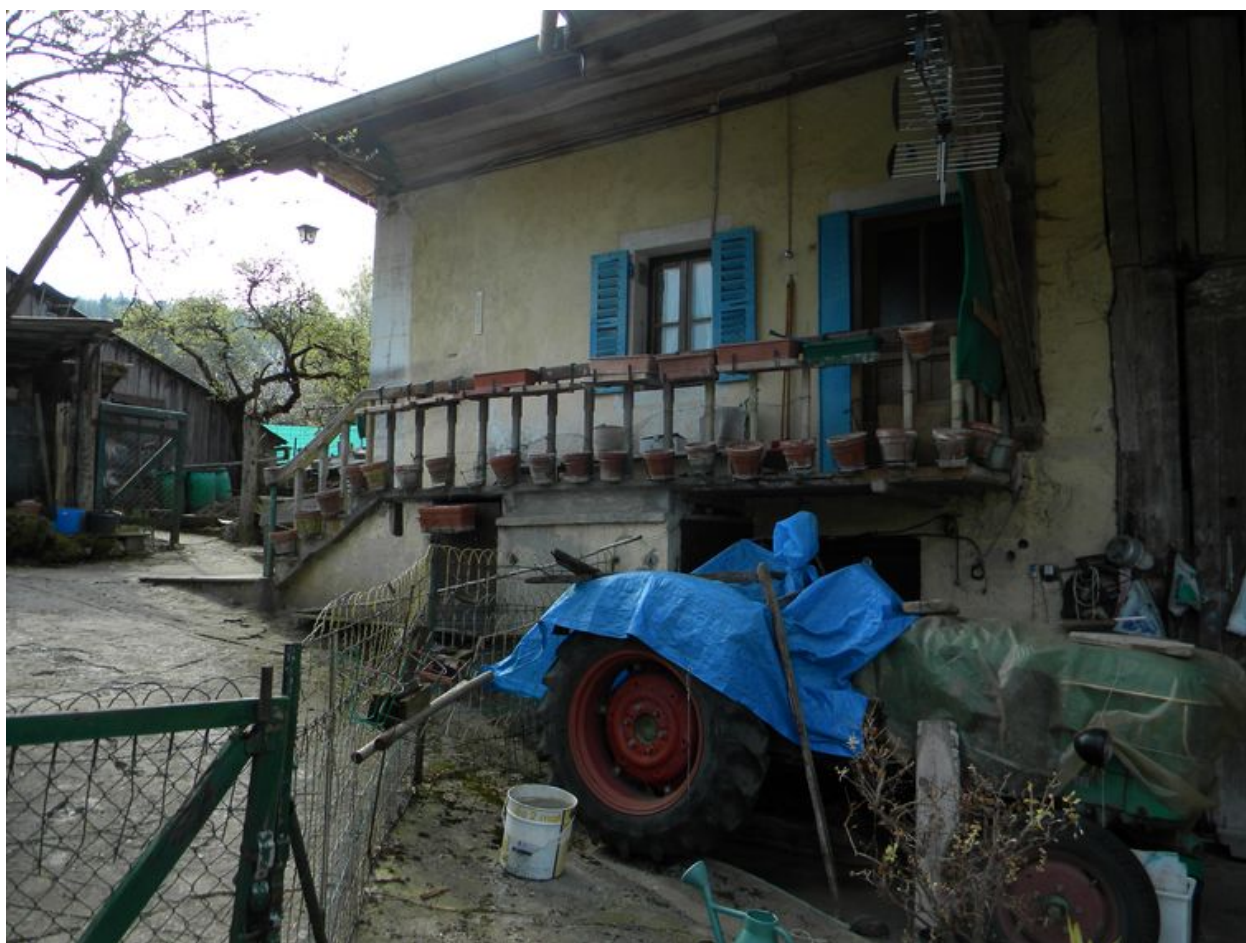
Vue de la façade sud du logis de la ferme est.
