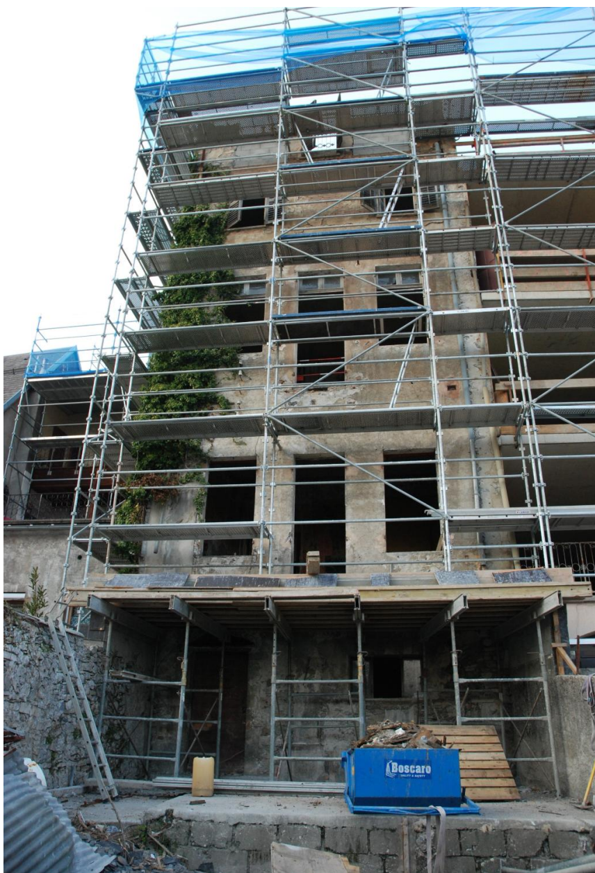
Elévation postérieure, vues depuis les jardins. Etat en mars 2019.
