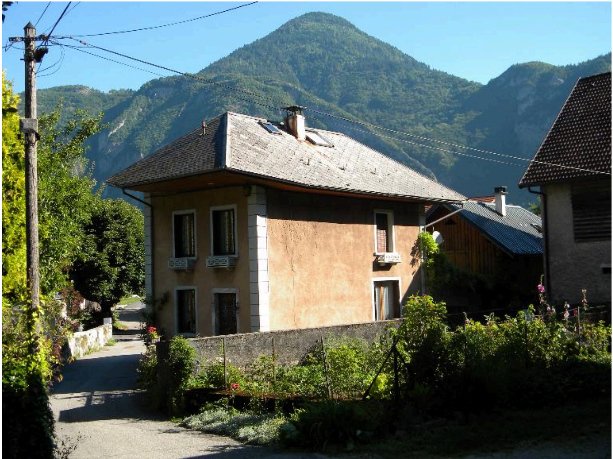
Vue d'ensemble d'une maison peinte avec chainages droits (2008 D4 822)
