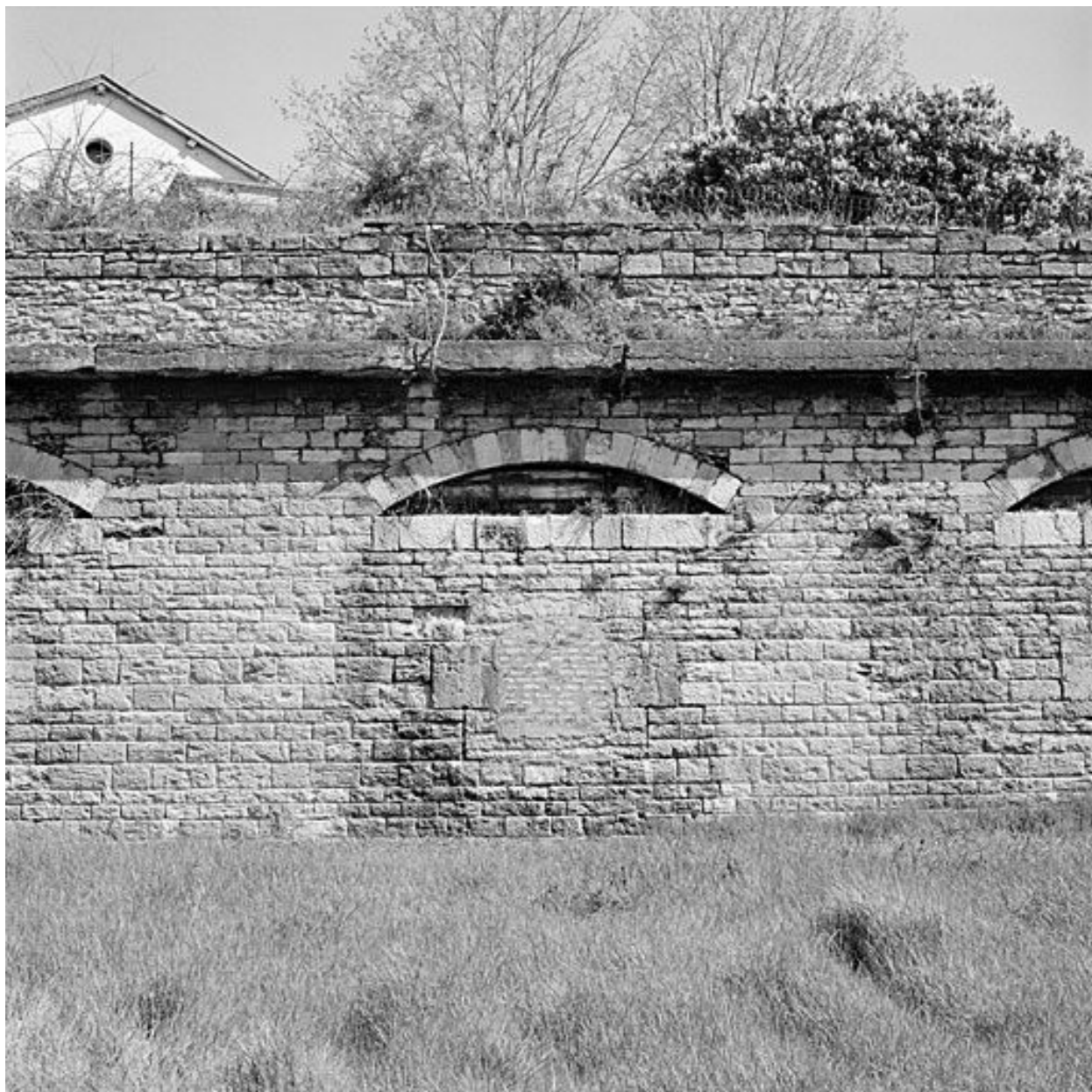
Ouverture d'une casemate murée du bastion 2
