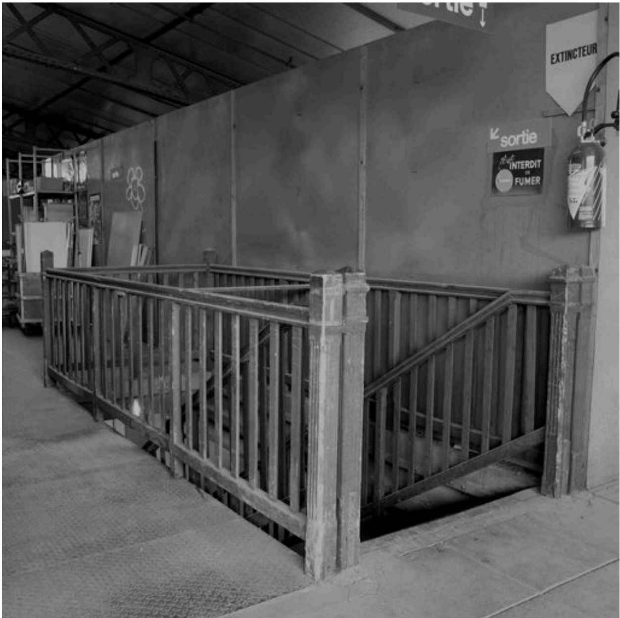
4e étage : escalier montant du 3e étage, le garde-corps
