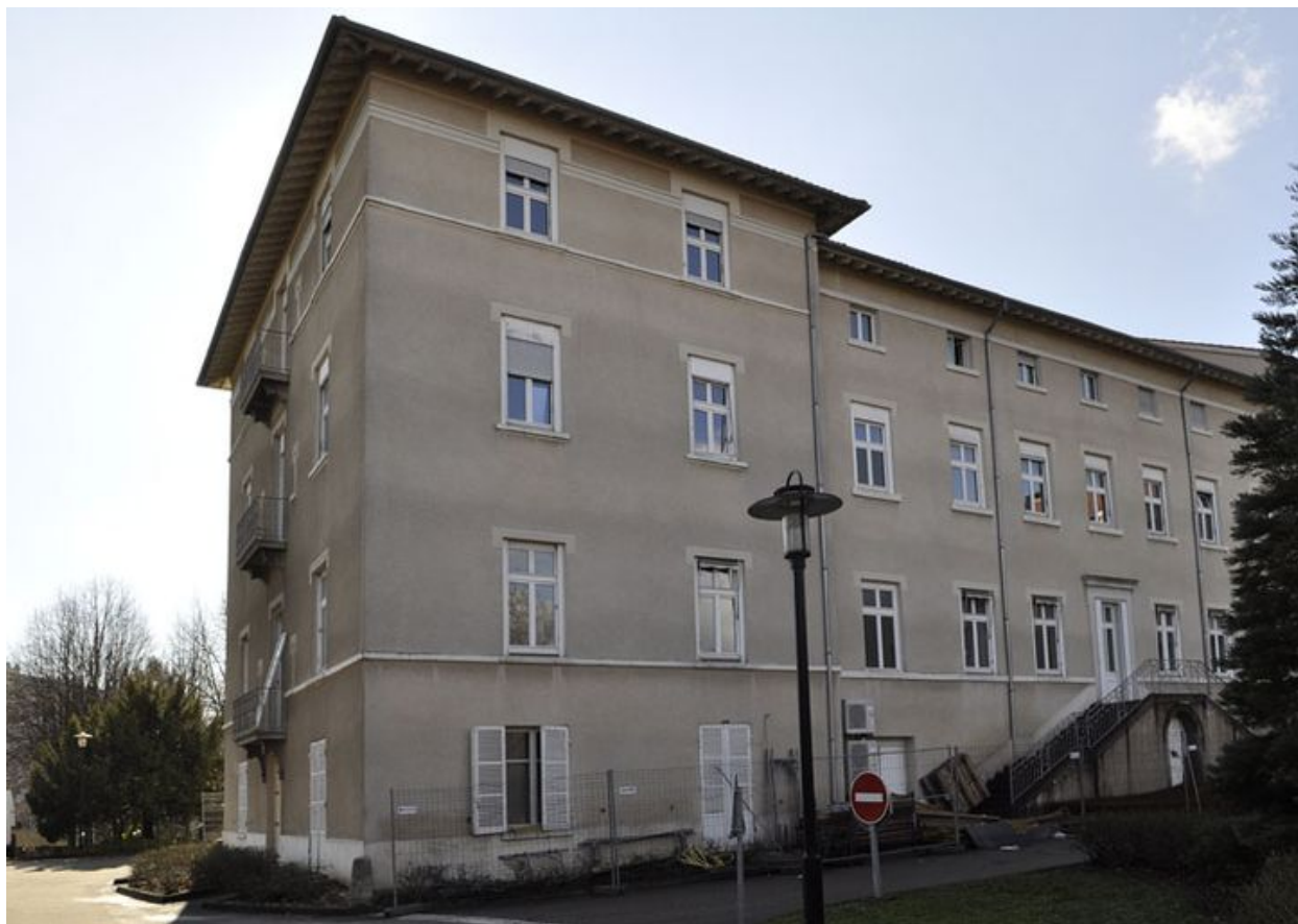
Aile C : façade nord
