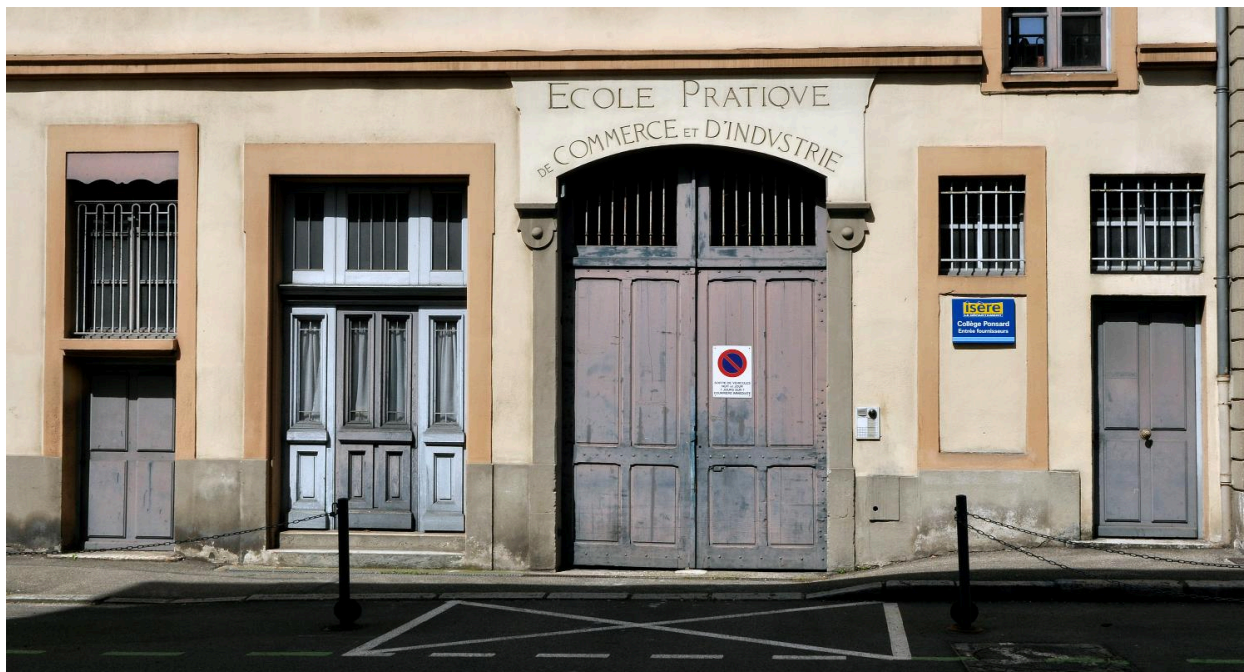
Élévation postérieure : ancienne entrée de l'Ecole pratique de commerce et d'industrie
