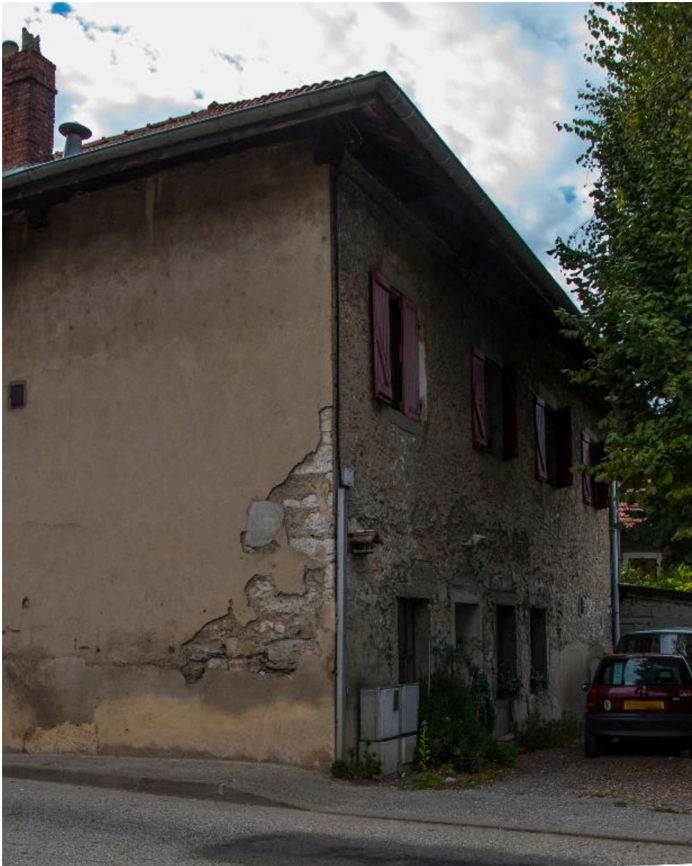
Élévation postérieure, au nord
