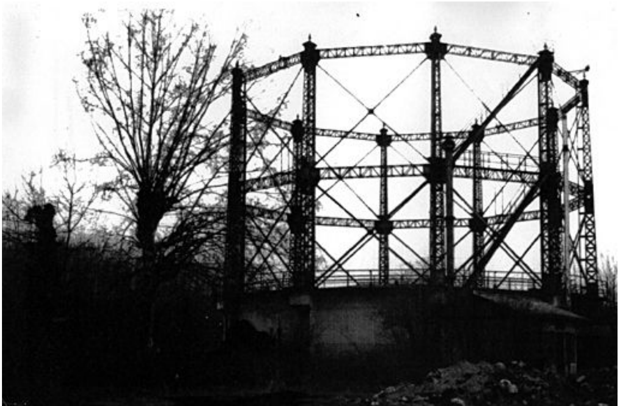
quatrième gazomètre en position basse (1930)
