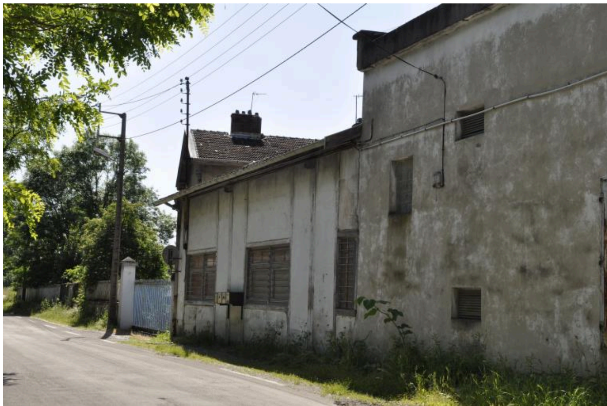
Vue d'ensemble ouest
