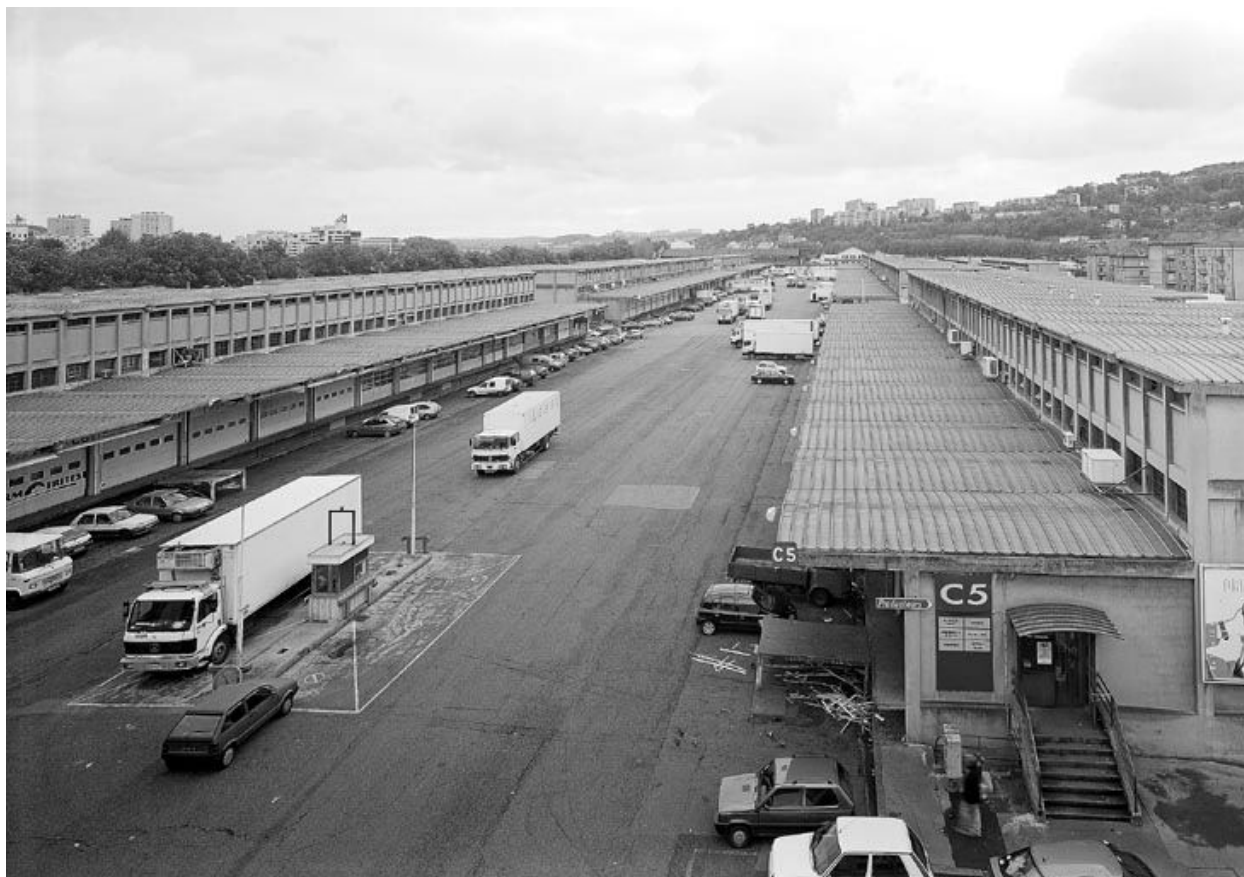
L'allée centrale depuis le toit-terrasse du bâtiment administratif situé à l'entrée du marché
