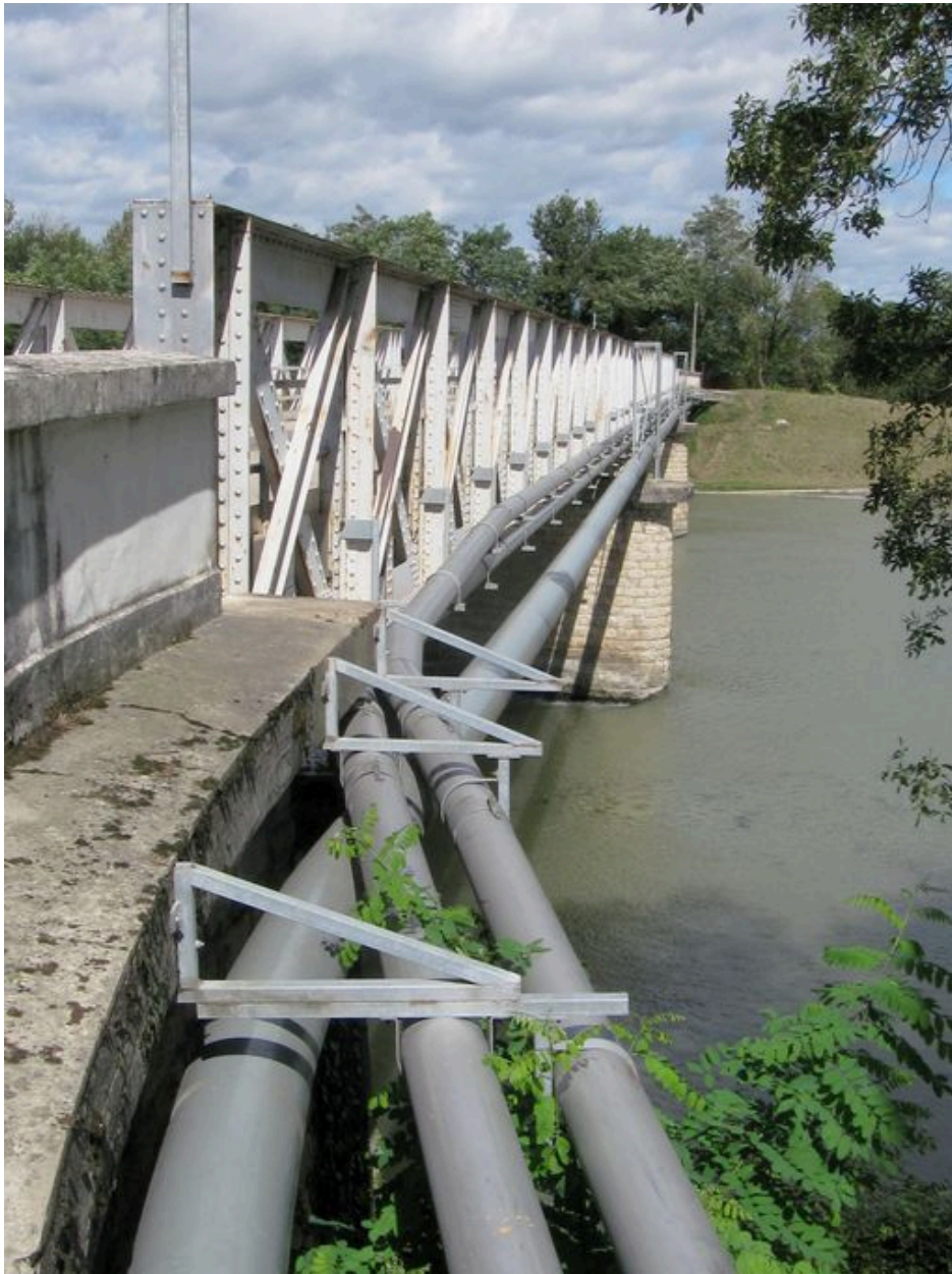
Vue générale, de côté, face amont (depuis la rive gauche)
