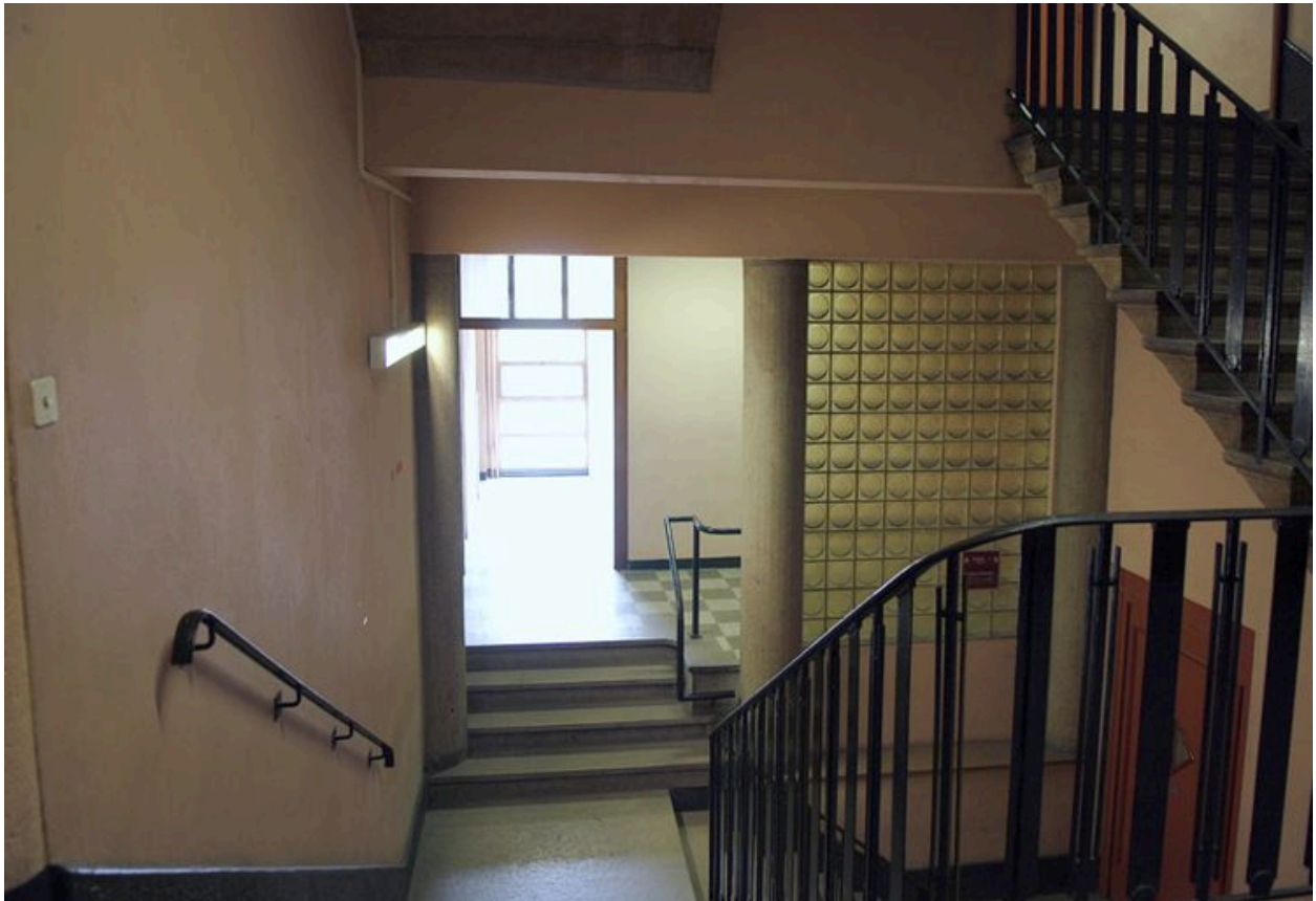
3e étage, escalier nord, palier de communication avec le bâtiment isara
