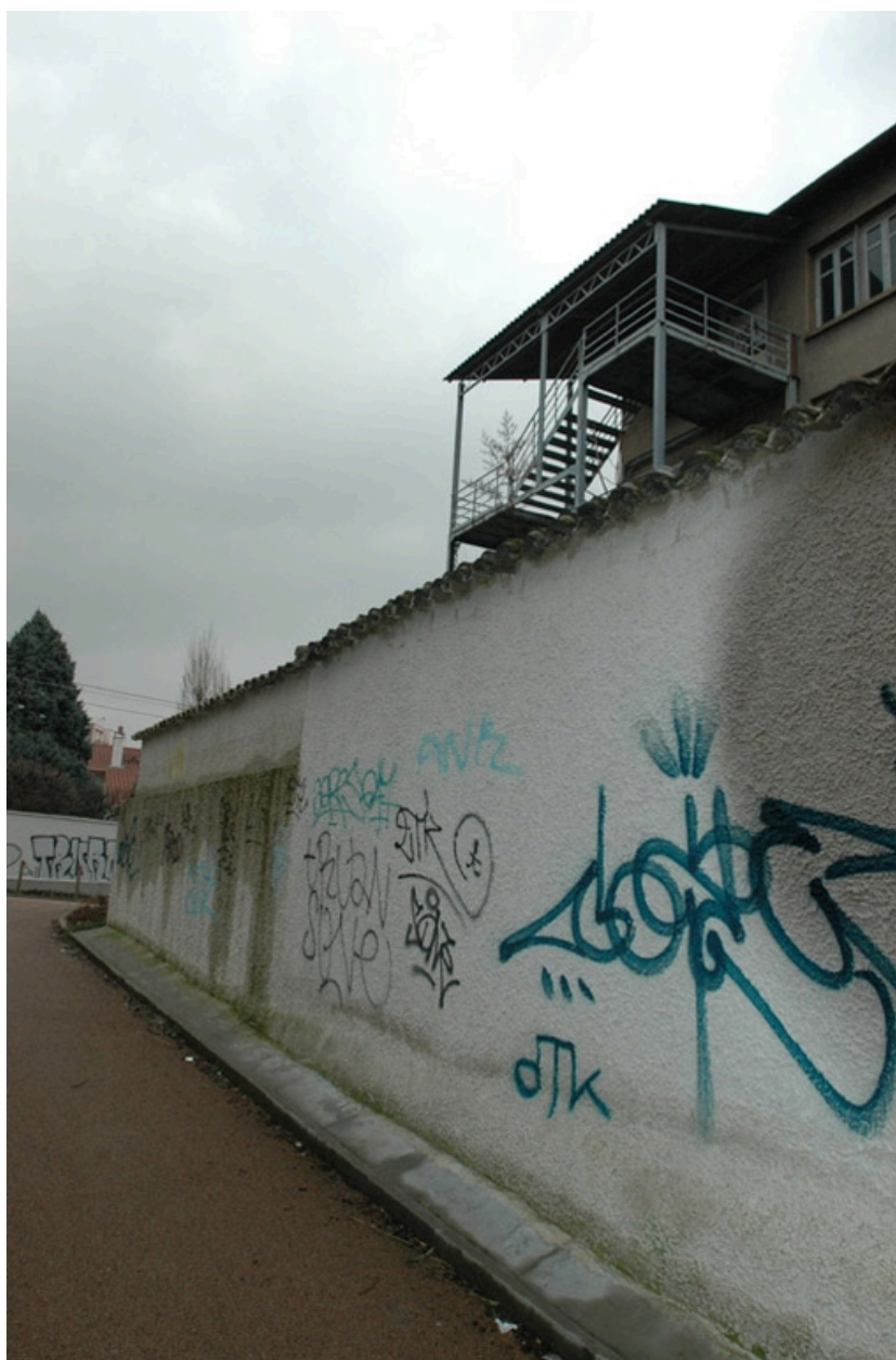
Façade latérale, vue sud ouest (issue de secours)
