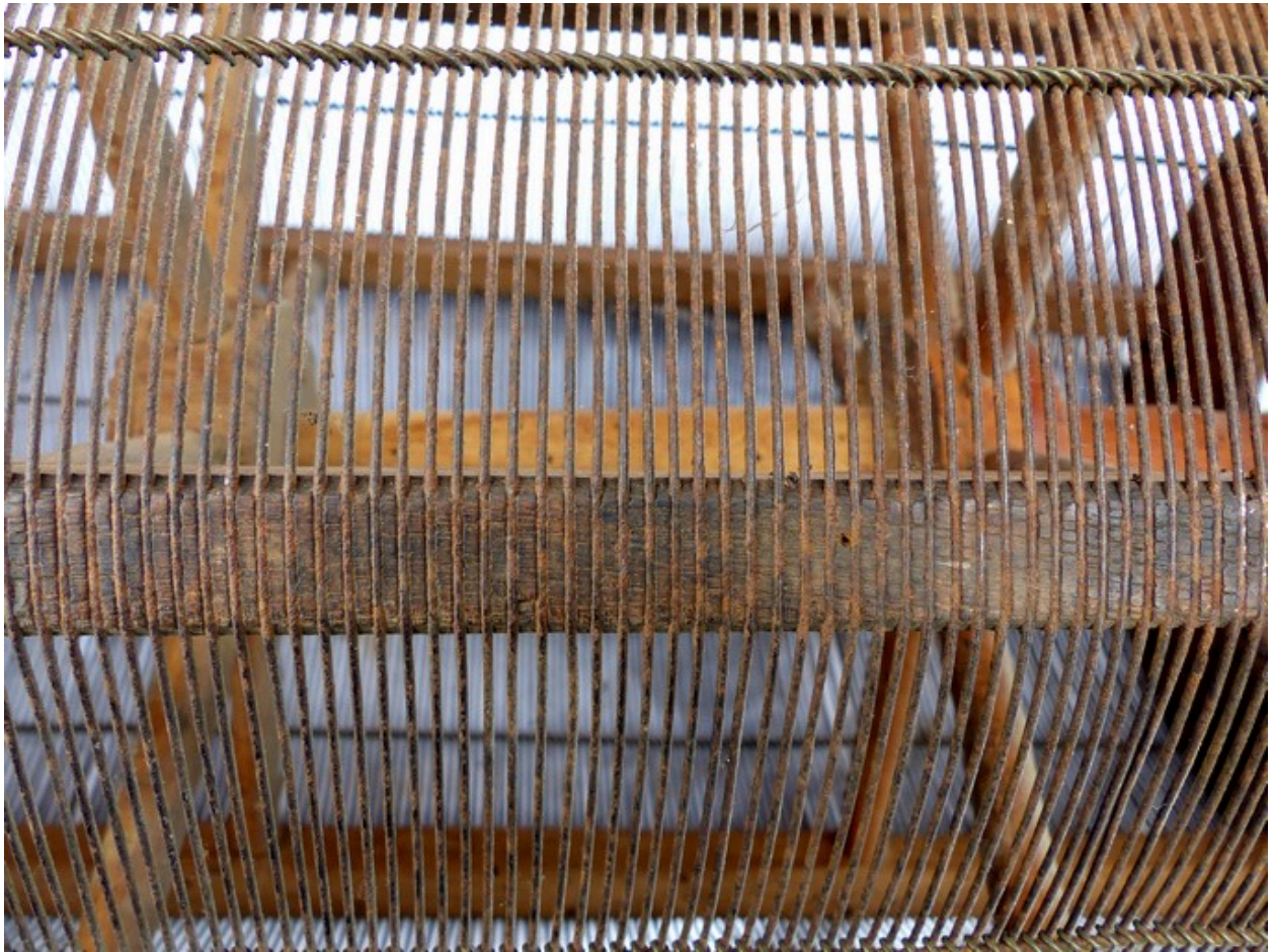
Détail du passage du fil métallique sur les tasseaux.
