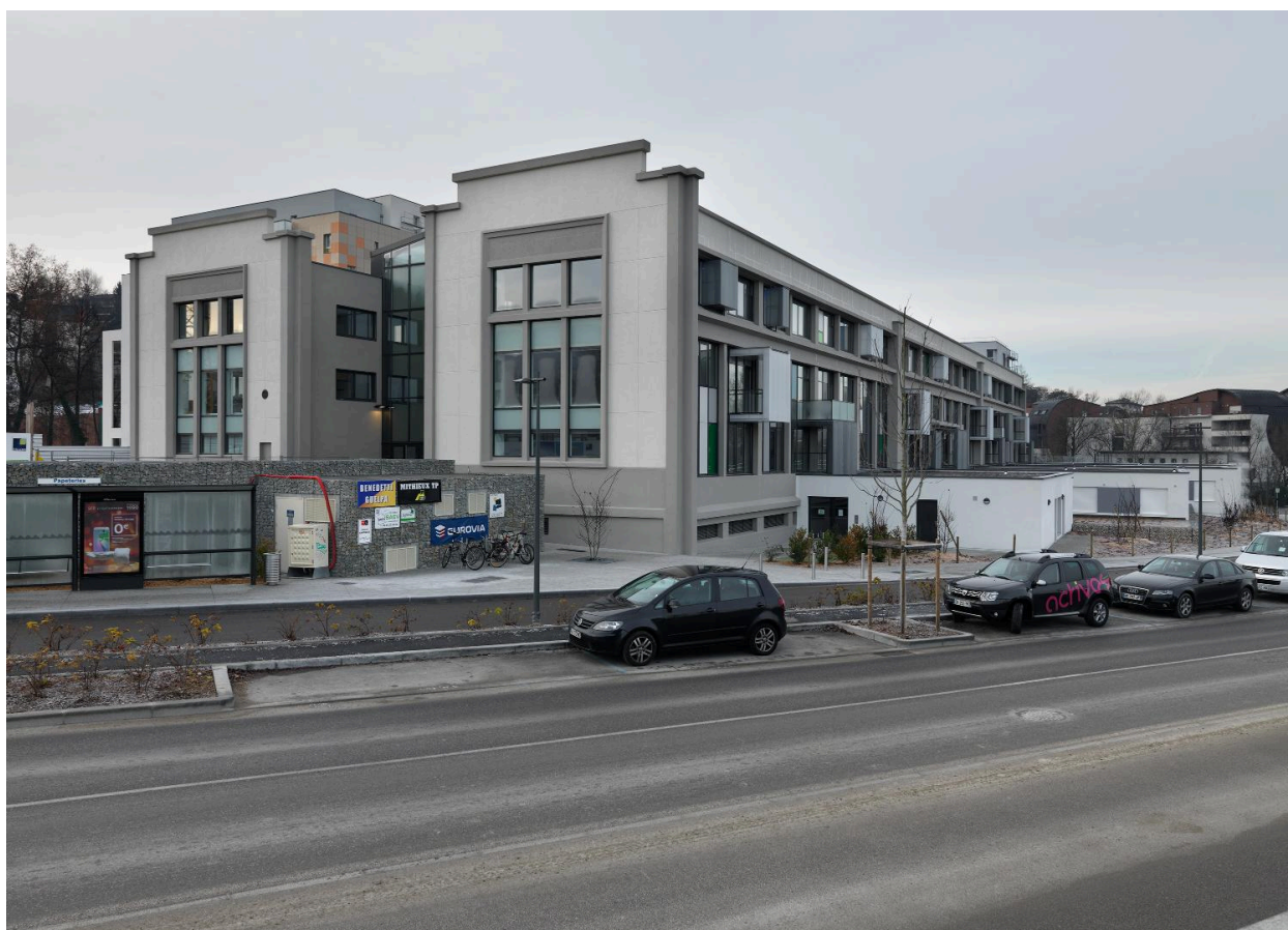
Papeteries de Cran-Gevrier/Annecy, vue intérieur après reconversion
