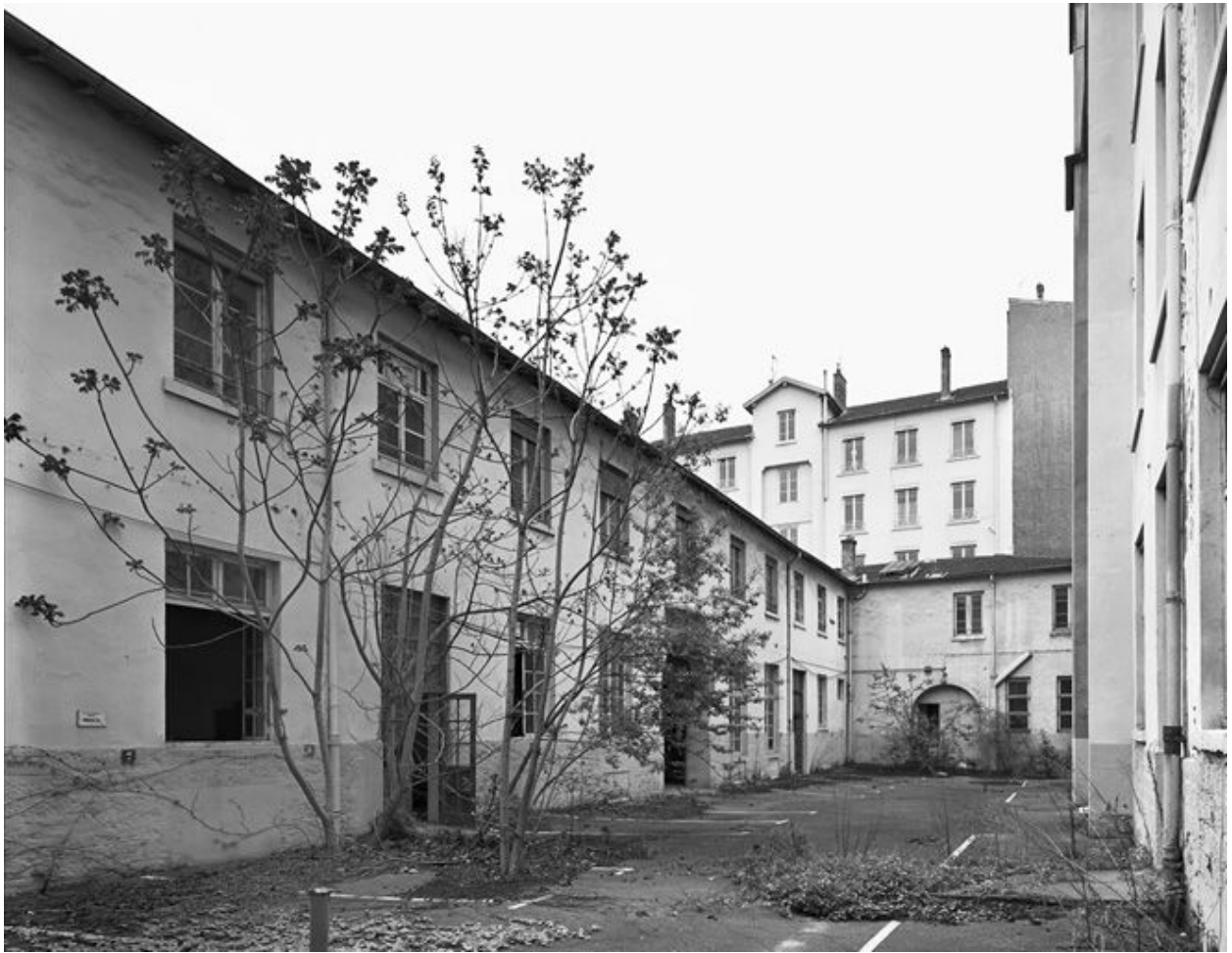
Cour 008, vue générale vers le sud
