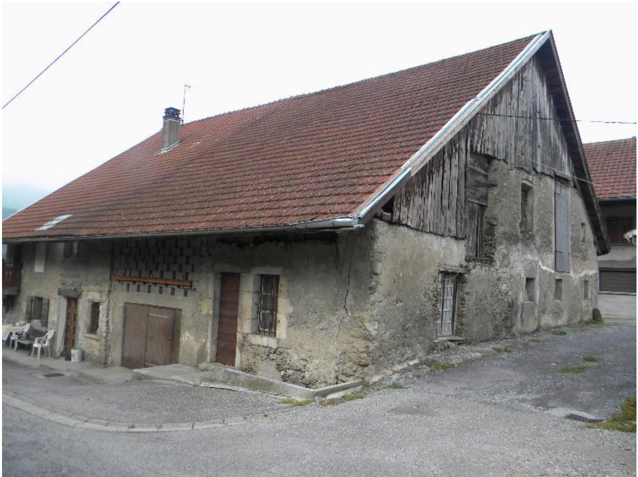
Vue de trois-quarts d'une ancienne ferme modifiée (2008 E10 1499).
