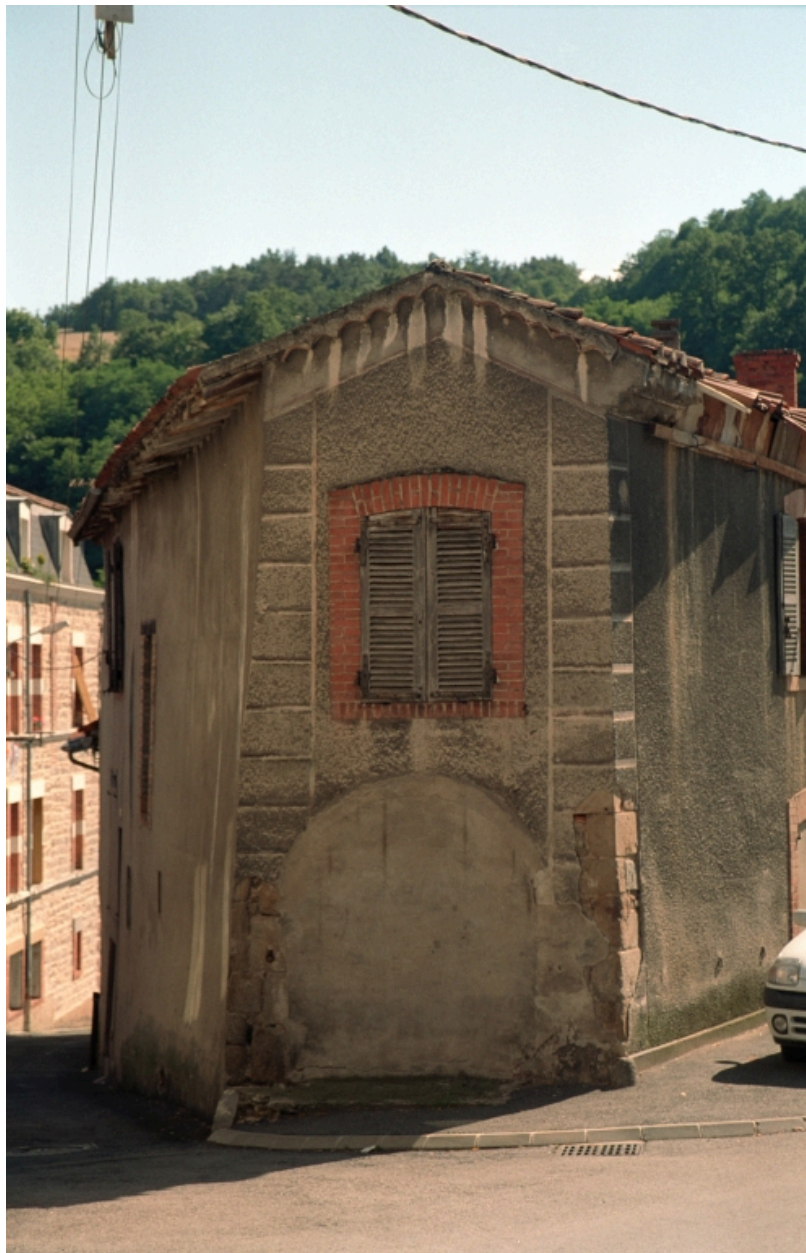
Boën, îlot 15, Lignon (rue du) 1. Vue générale de la façade sur rue.
