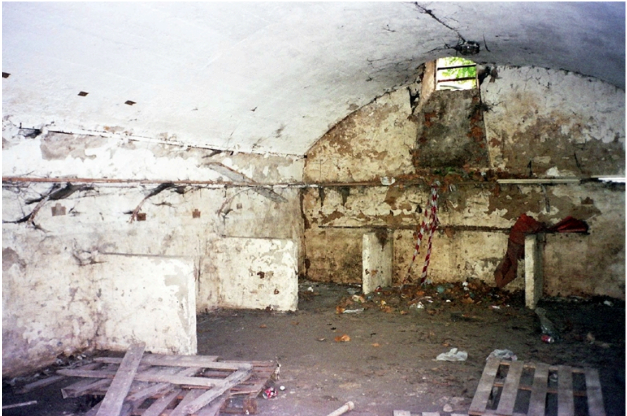
Vue d'ensemble caves n° 3
