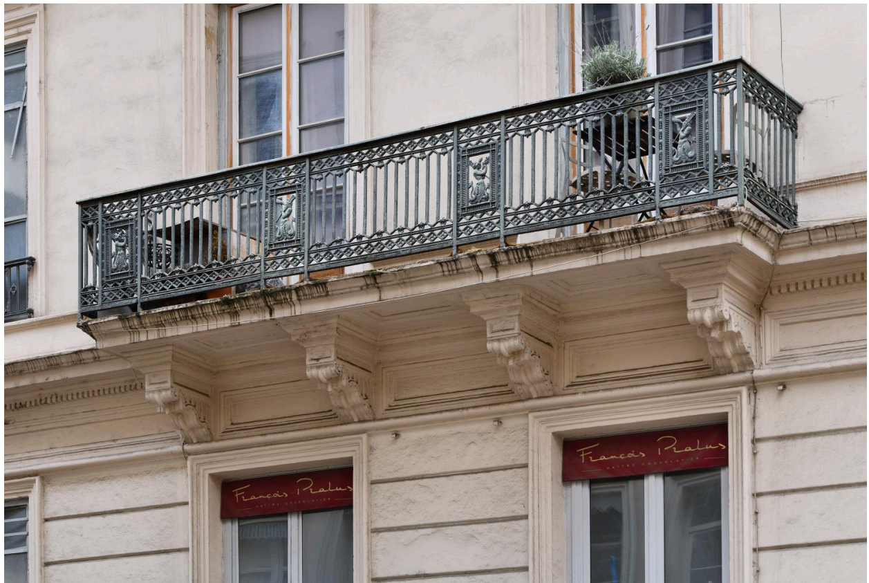
L'un des balcons sur la rue de Brest
