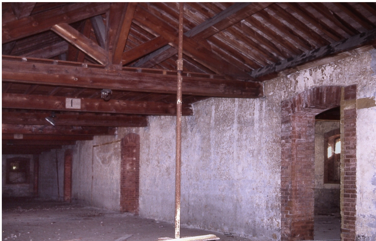
Charpente en bois
