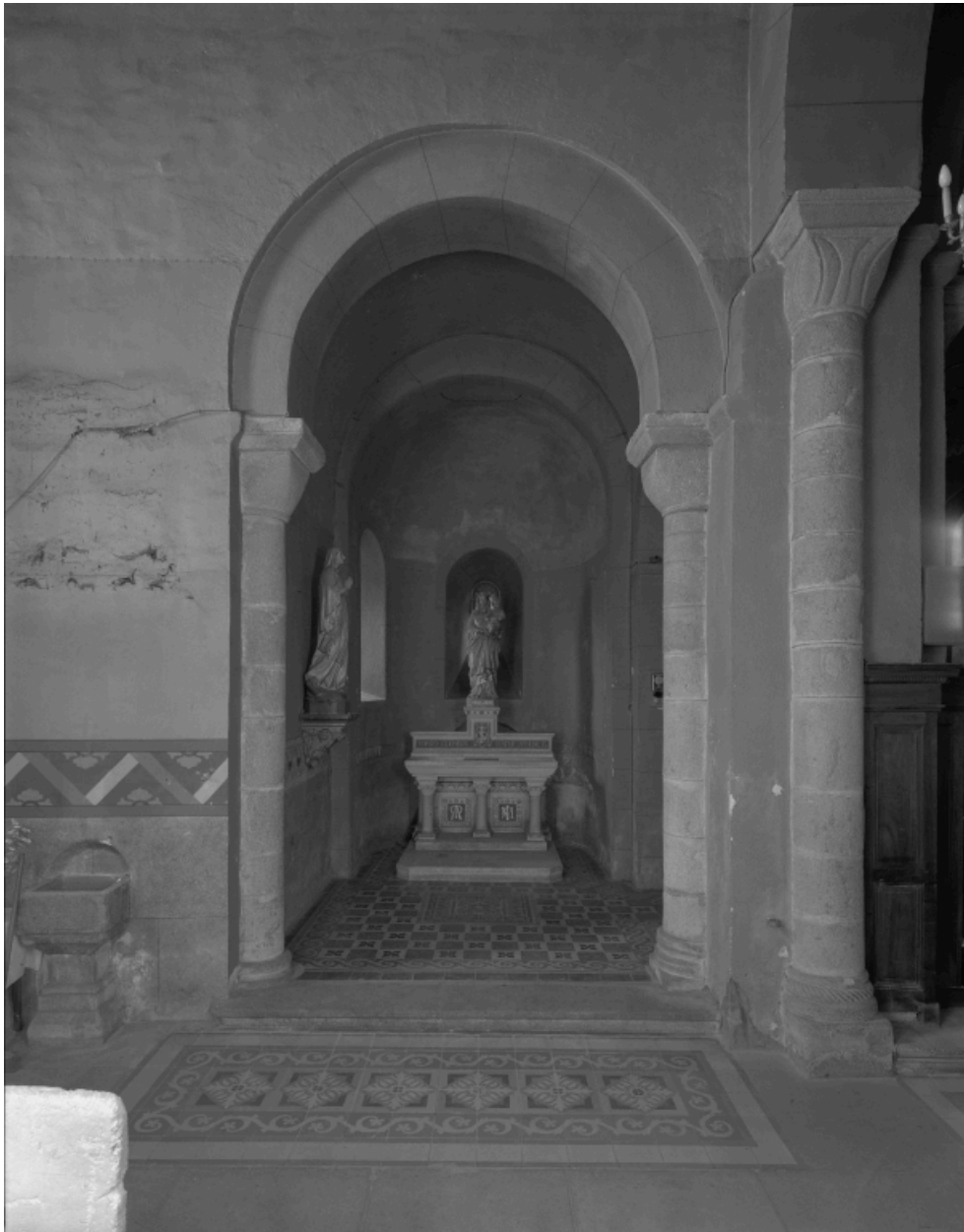
Vue intérieure de l'absidiole nord.
