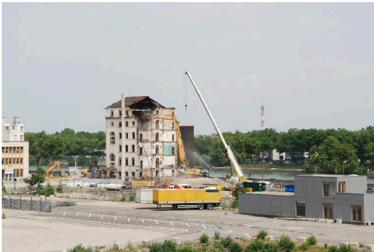
L'immeuble en cours de démolition
