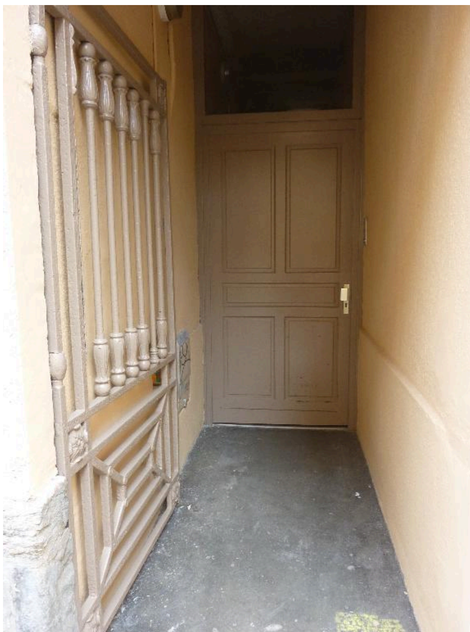
Détail ferronnerie entrée
