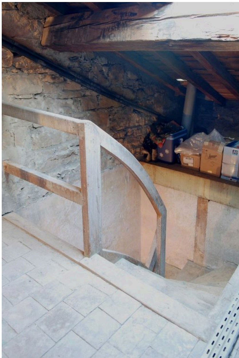
Bâtiment 512, escalier menant aux combles
