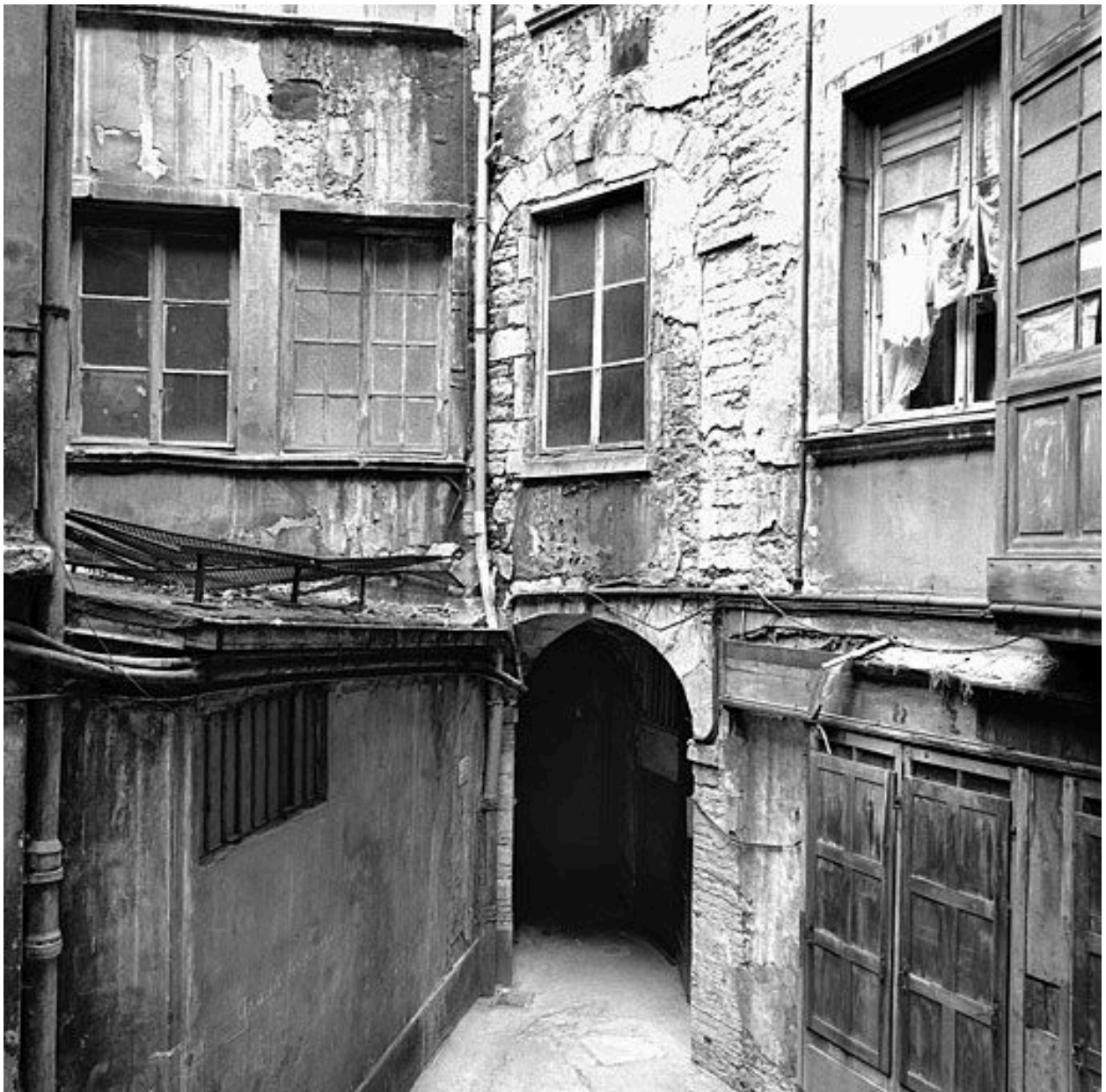
Allée vue depuis la cour et baie en arc surbaissé au-dessus
