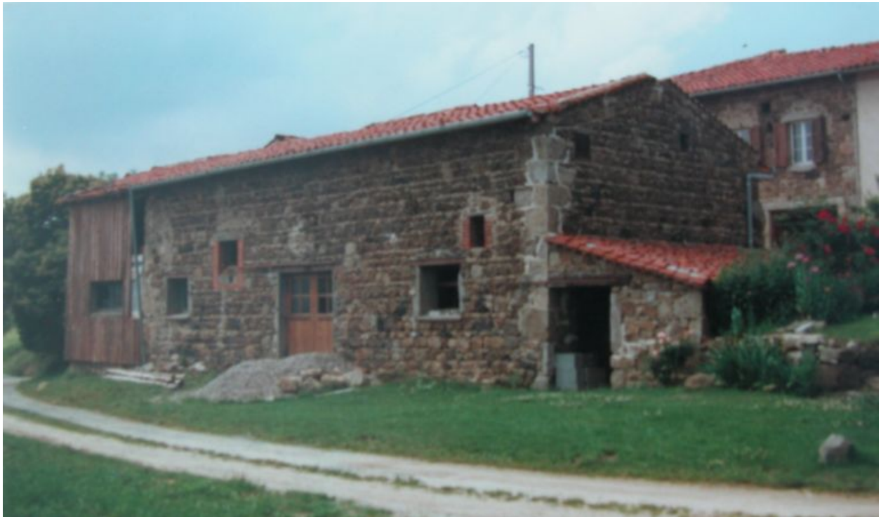
Photographie ancienne du hangar avant transformation.
