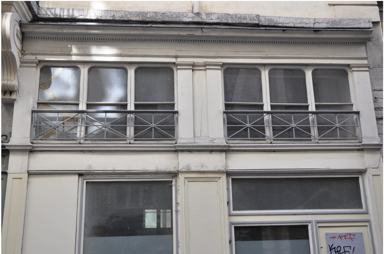
Vue rapprochée sur l'entresol au 10, rue Royale
