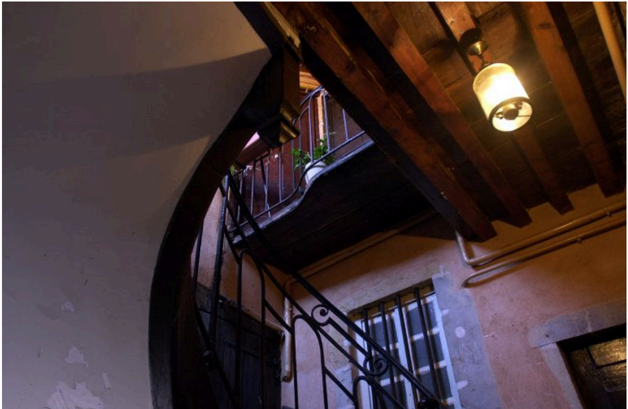
Pavillon d'escalier, petit escalier desservant la pièce sommitale
