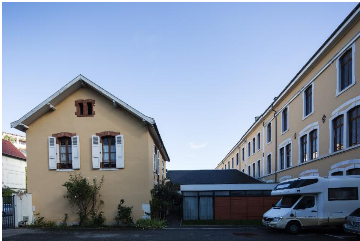
Cour nord : bâtiment 19e, maison du gardien, bâtiment de la demi-pension.
