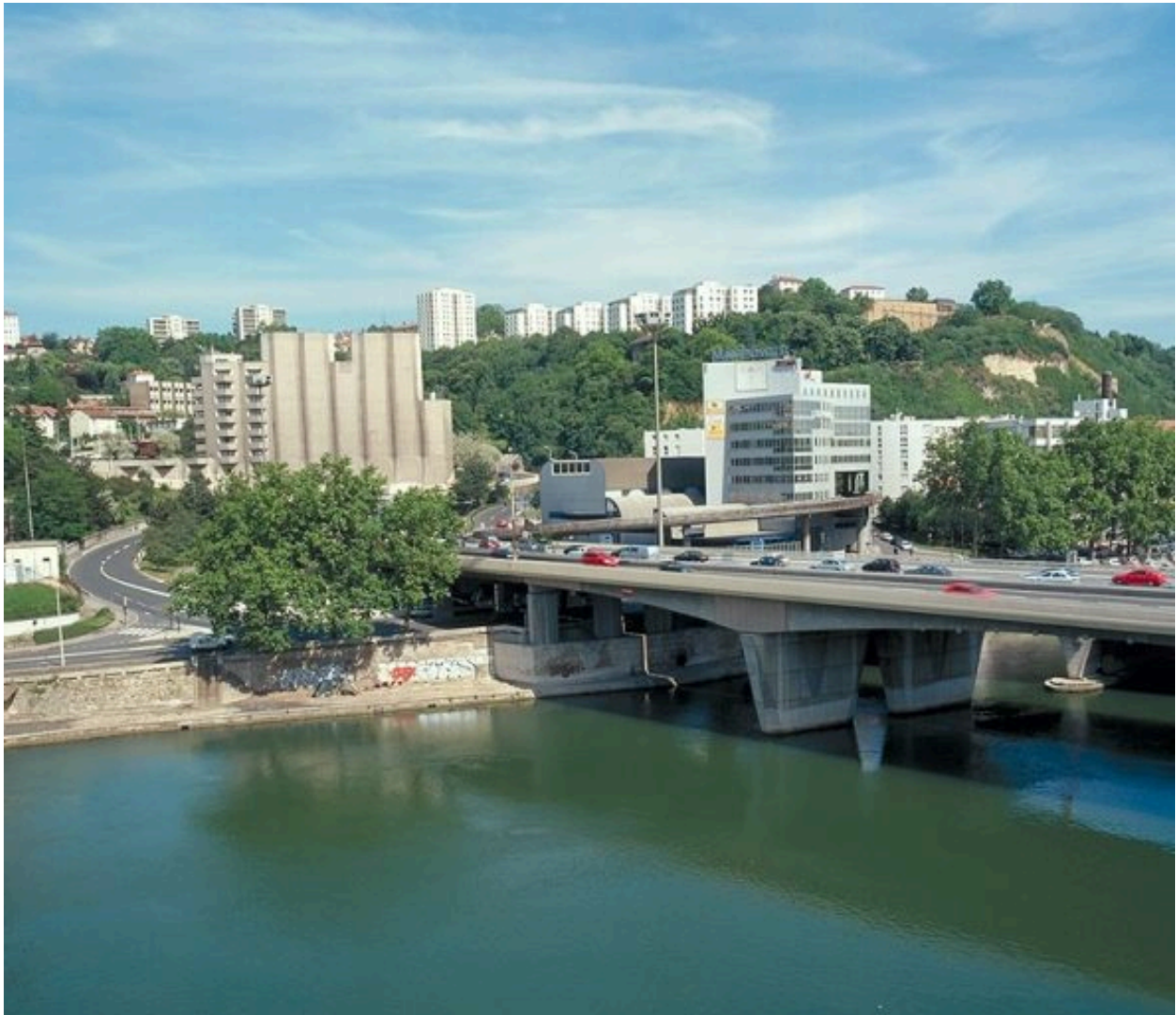
Vue d'ensemble du pont et de l'entrée du tunnel sous Fourvière depuis le poste d'aiguillage 1 de Lyon-Perrache
