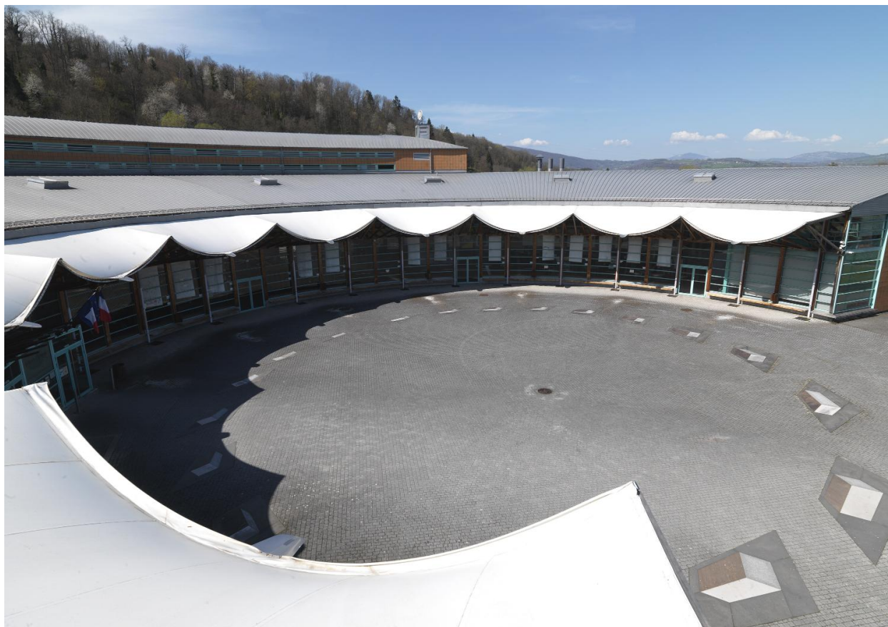
Vue d'ensemble, depuis le toit.
