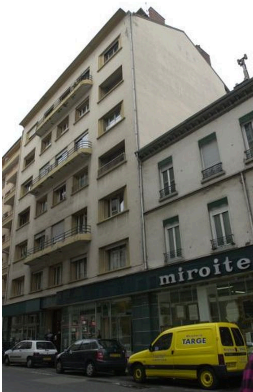
Vue générale de l'élévation
