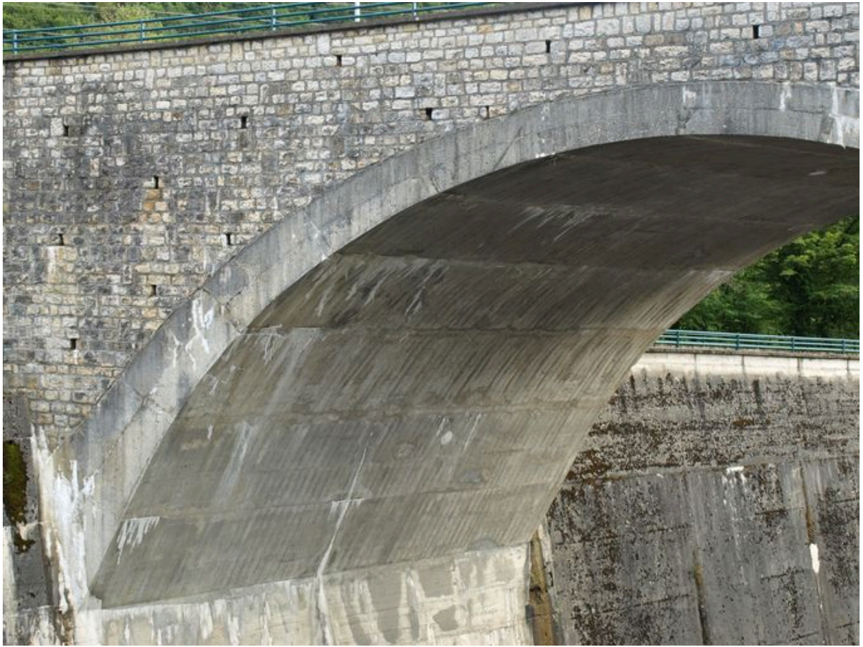
Voûte, vue partielle
