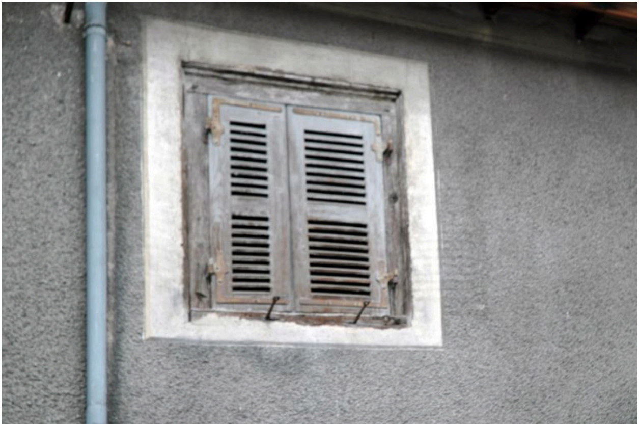
Baie de l'étage en surcroît avec encadrement de bois.
