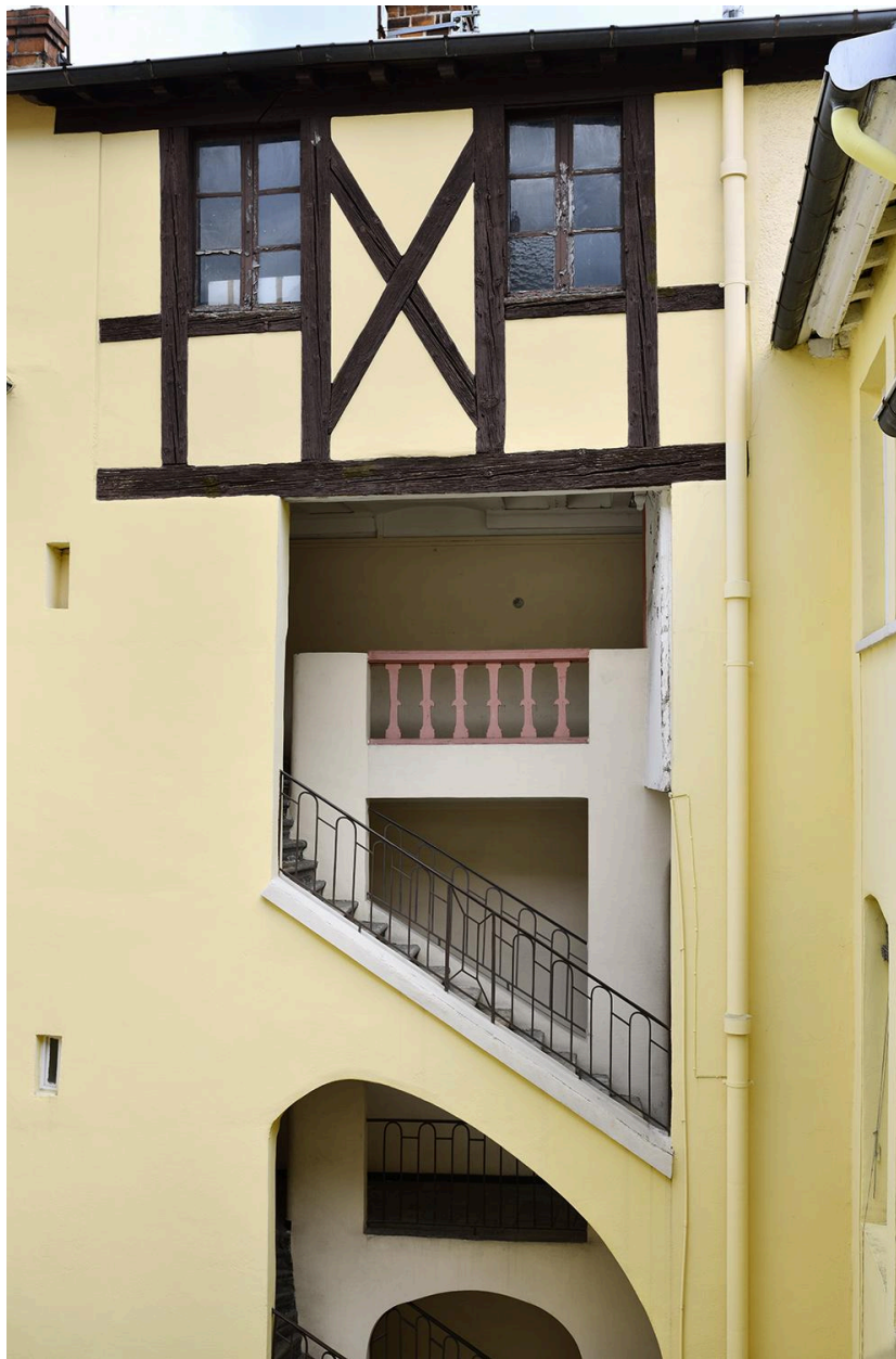
Escalier : étages supérieurs
