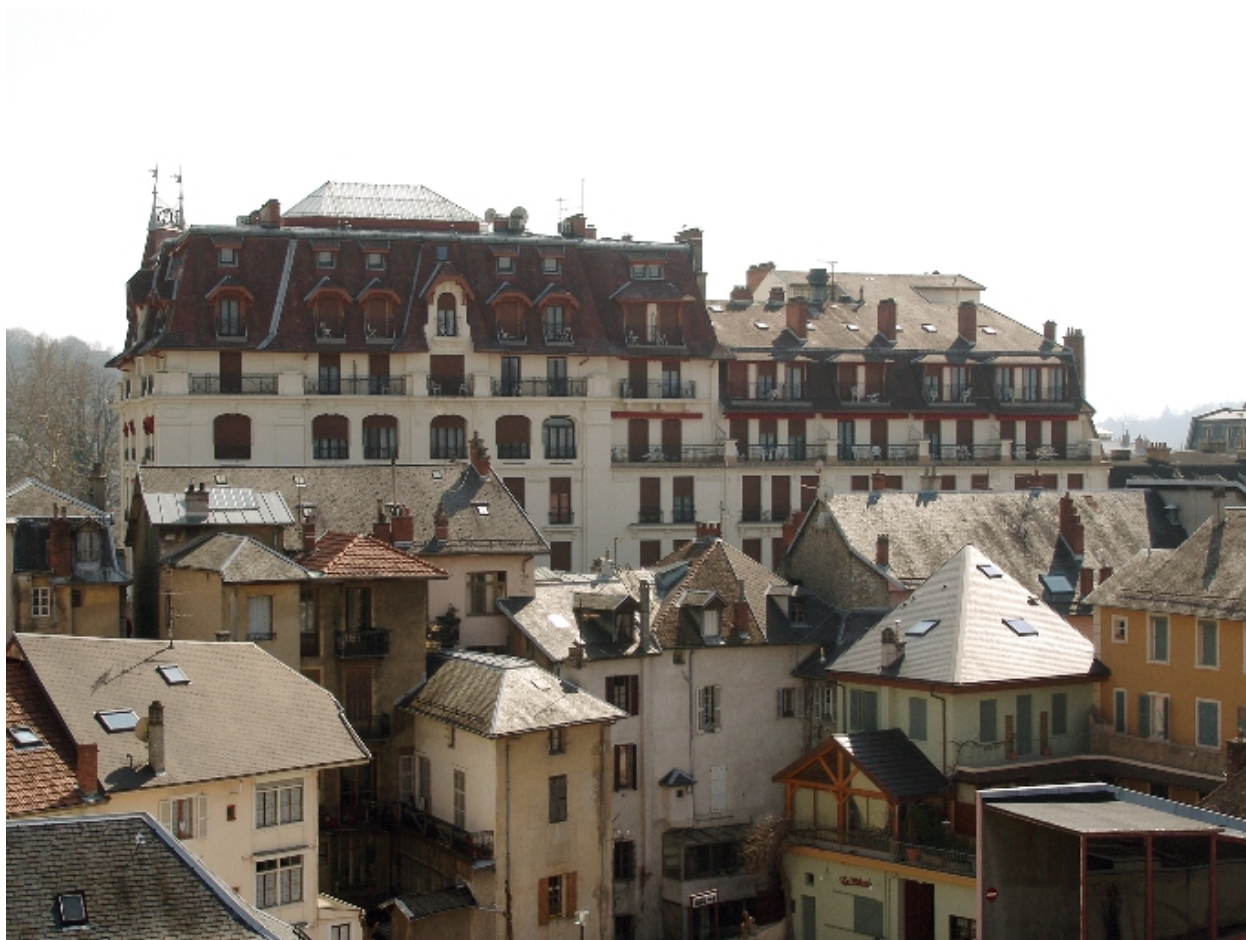
Vue générale prise du nord
